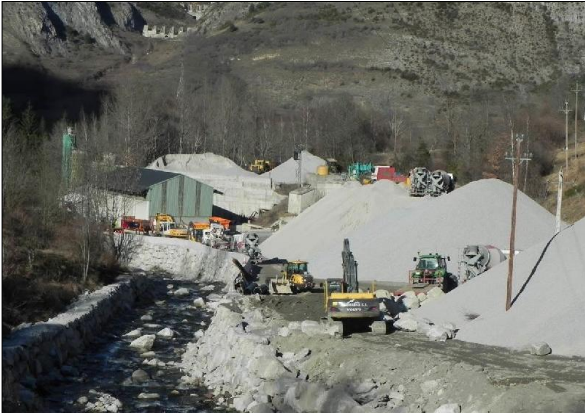
Imatge 2. Vista de l'àmbit en sentit N-S, des de la pista de Valarties-Aiguamog, que transcorre pel marge esquerre del riu Valarties, en escollera. Al fons, a esquerra, s'observa el barranc des Artigues (amb unes obres de regulació) que tributa per la banda contrària al riu Garona.
