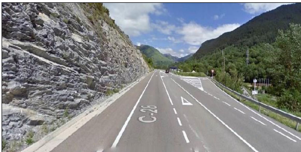
Imatge 17. La carretera C-28 en sentit O-E, just abans d'arribar al desviament des d'on arrenca el vial asfaltat que duu a l'àmbit. La carretera disposa de carril d'incorporació en ambdós sentits.
