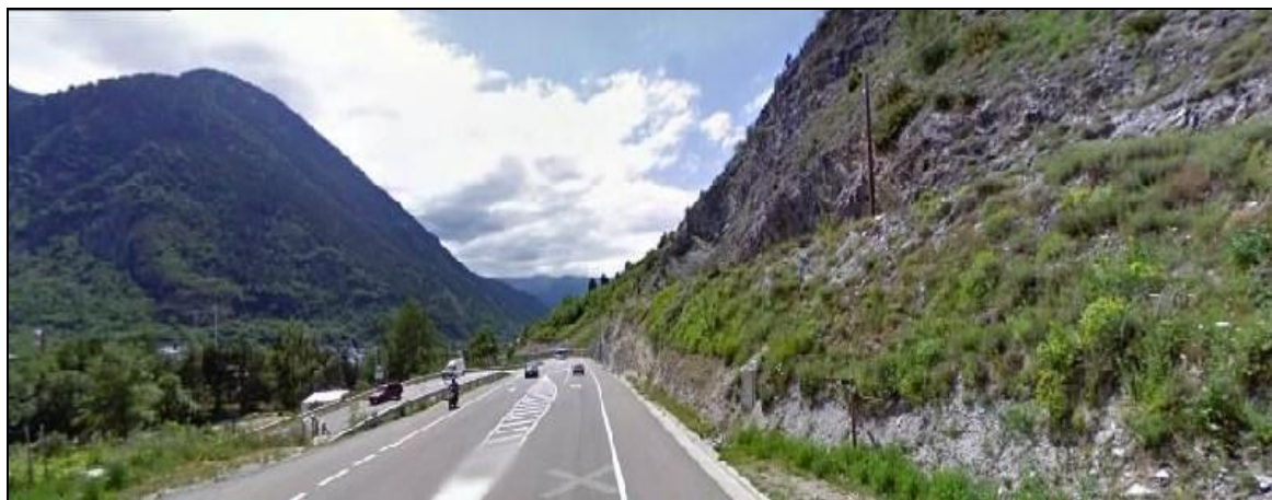
Imatge 18. La carretera C-28 en sentit contrari, és a dir, E-O, just abans d'arribar al desviament que dona accés a la pista que duu a l'àmbit.
